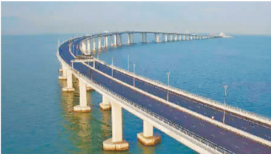
上万建设者用青春、热血、智慧和汗水浇筑的港珠澳大桥。据网络
