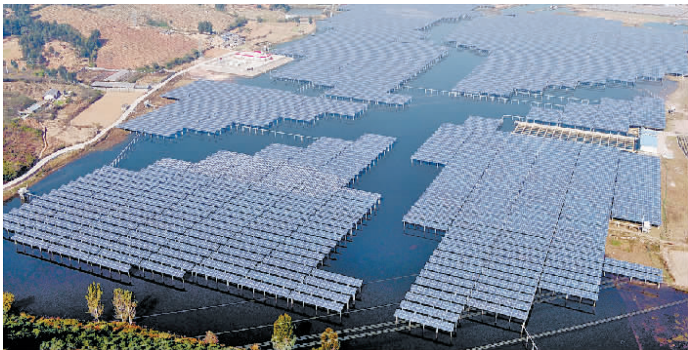
从高空俯瞰西昌市西溪乡兴国寺水库 20MWp(兆瓦)光伏电站项目。 本报记者 冷文浩 摄
