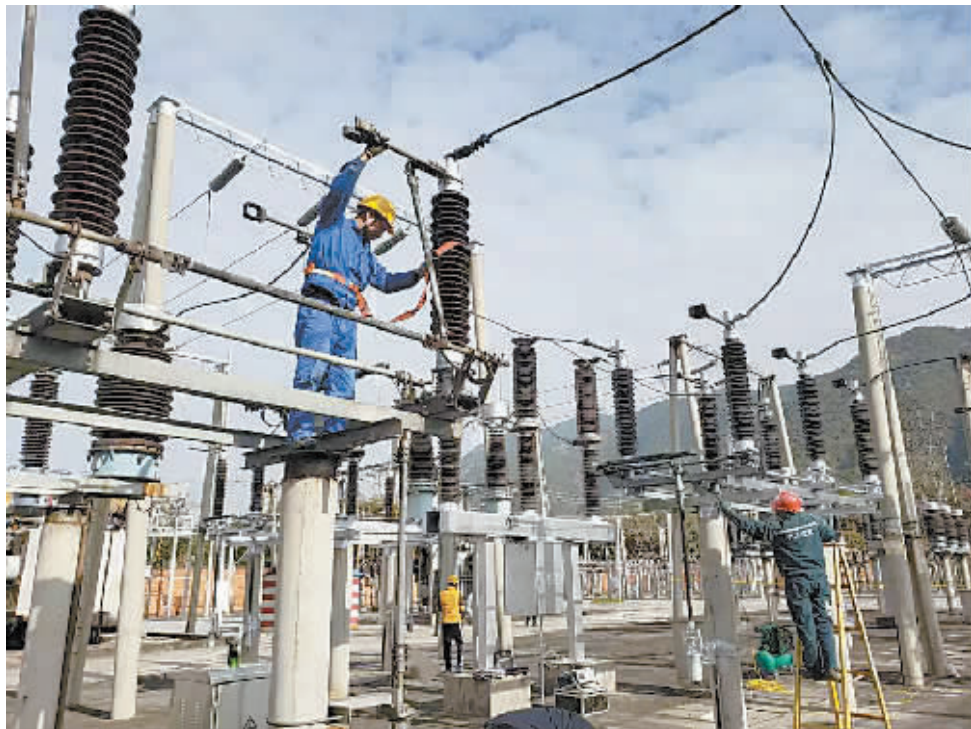
工作人员对变电站进行维修。
